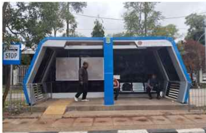
Gambar 3.7 Pembangunan Smart Halte Transpatriot
